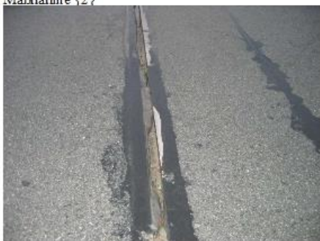
FUGENSPALT VERSCHMUTZT
