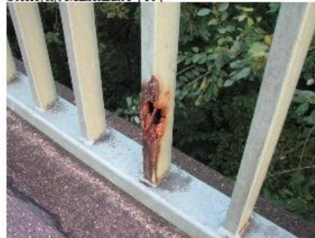
FÜLLSTAB DURCHGEROSTET
