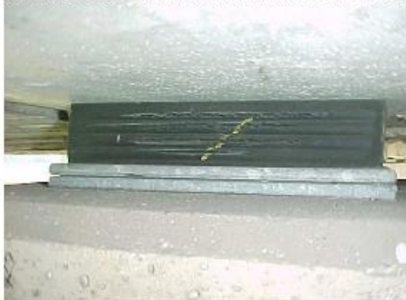
ELASTOMERLAGER RISSIG
