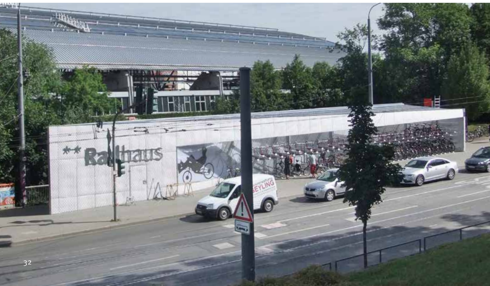
Bike+Ride-Anlage „Radhaus II“ in Erfurt am Hauptbahnhof
