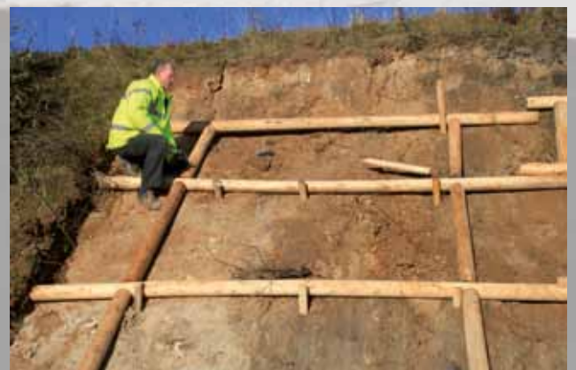
Verbau mit Derbstangen
