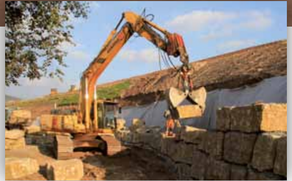
Bau von Trockenmauern
