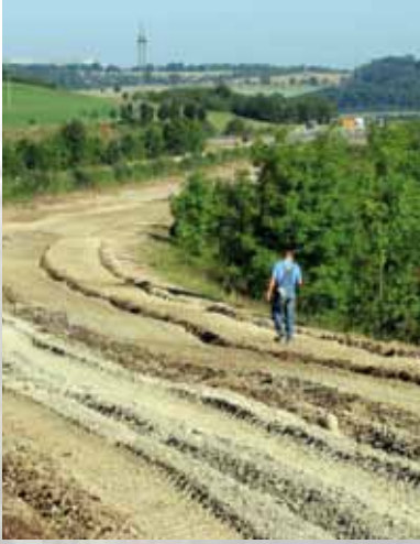
Rückbau der BAB A4 östlich von Eisenach
