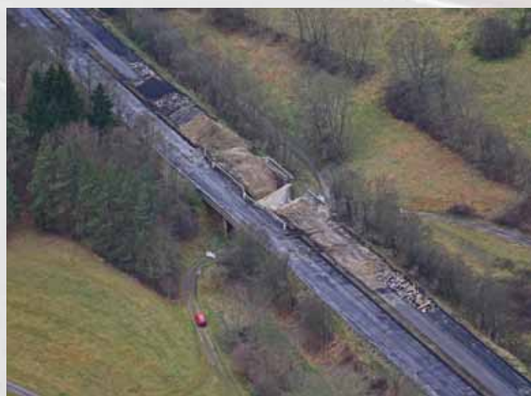
Beginn des Rückbaues der BAB A4 im Winter 2014/2015
