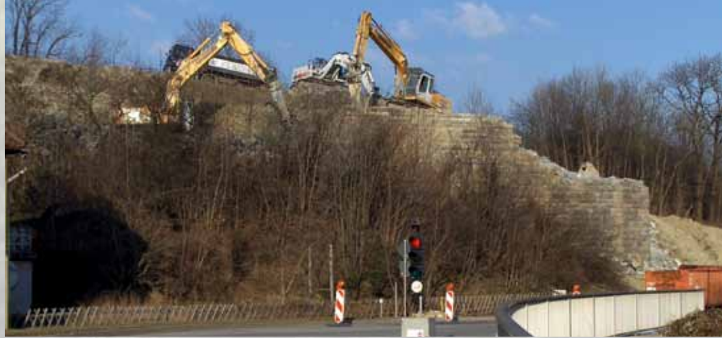
Abbruch der alten Hörselbrücke bei Sättelstädt
