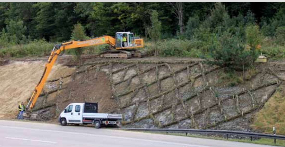
Ingenieurbiologische Sicherungsbauweisen im Bereich der BAB A9, Anschlussstellen Lederhose und Eisenberg.
