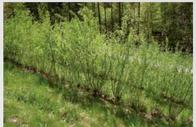
Böschungssanierung im Bereich Teufelstalbrücke
