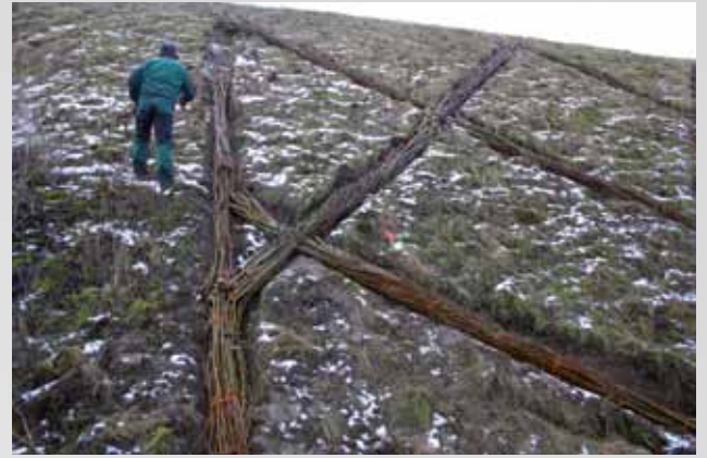
Einbau der Lebendfaschinen am Lärmschutzwall Dorna
