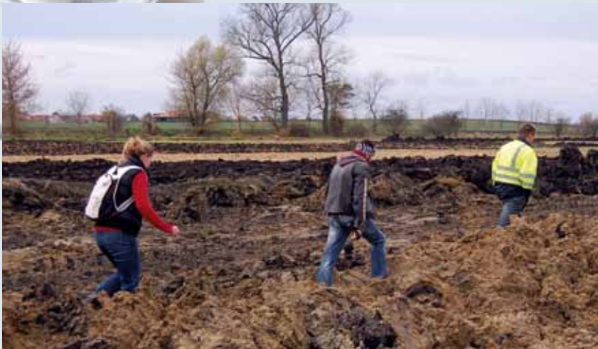
Begehung der Baustelle
