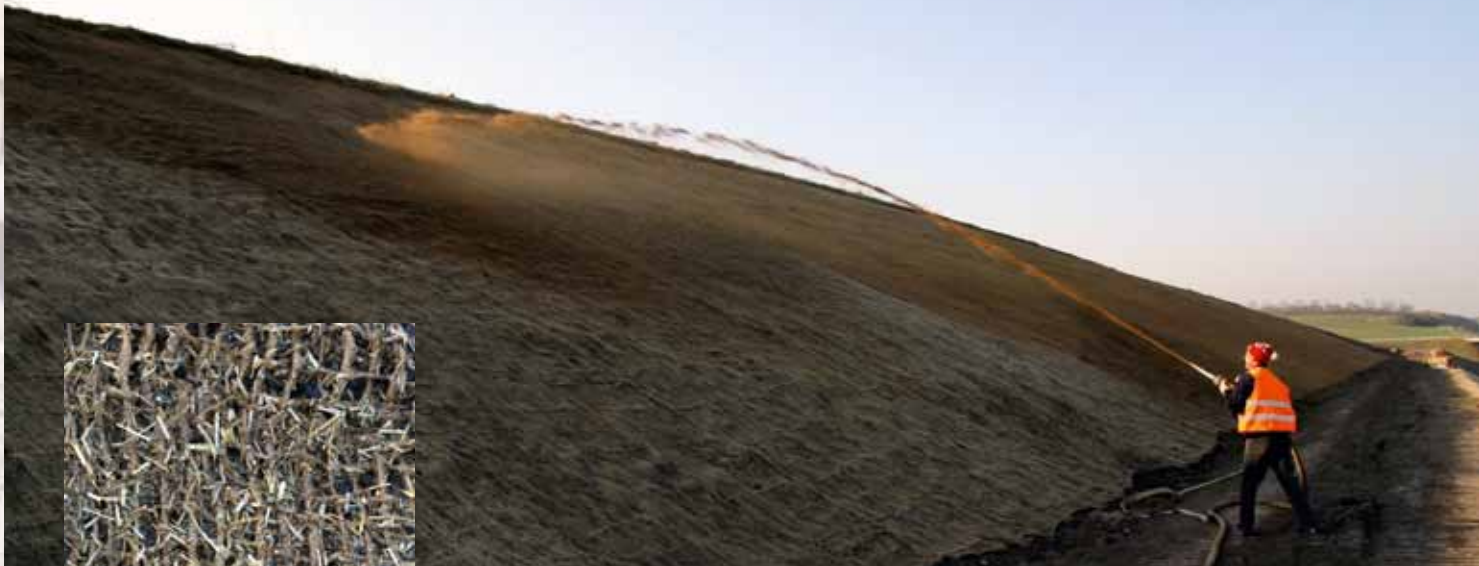
Nassansaat an Autobahnböschung bei Schwerborn
