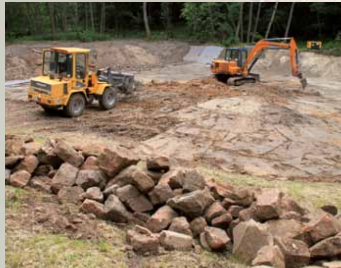
Abdichtung eines Teiches an der Neumühle
