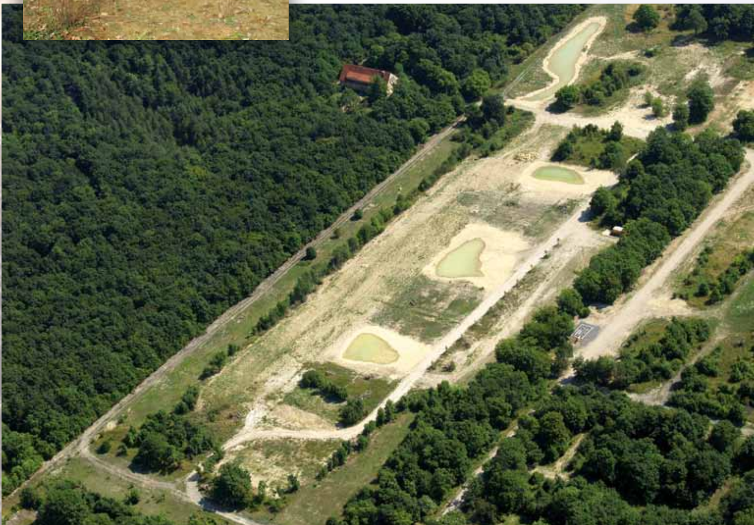
Maßnahmefläche nach Bauende
