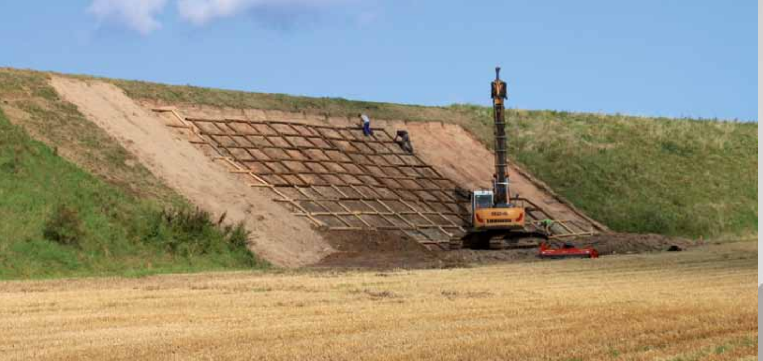
Ingenieurbiologische Sicherungsbauweisen im Bereich der BAB A9, Anschlussstellen Lederhose und Eisenberg.
