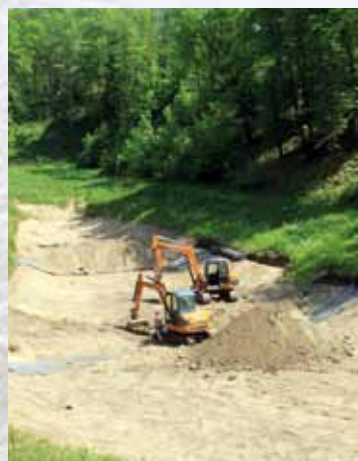
Teichbau an der Neumühle
