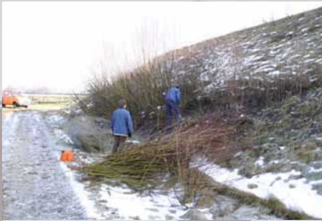
Schnitt von Steckhölzern und Weidenfaschinen bei Dorna
