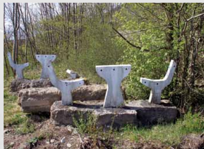
Abbruch des ehemaligen Parkplatz in den Hörselbergen
