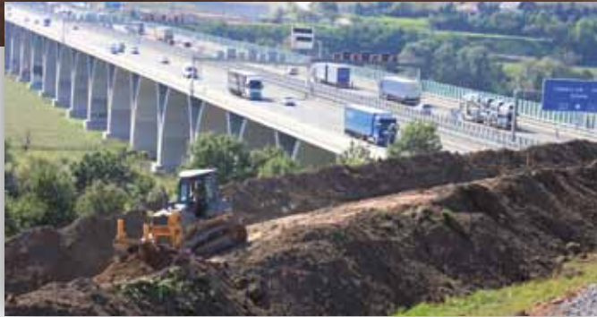
Wegebau auf dem Lobdeburgtunnel
