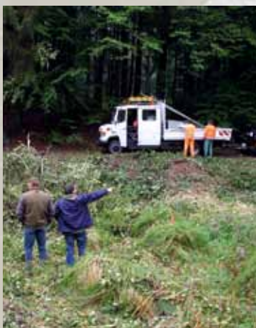
Baubeginn im Eselsgrund
