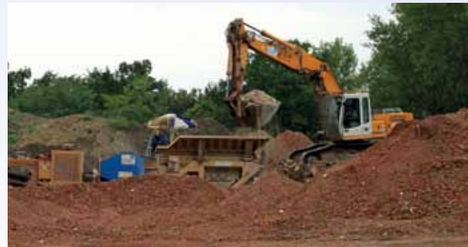
Entsiegelung von Wegen und Plätzen
