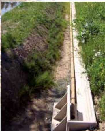
Amphibienleiteinrichtung und -durchlass während der Bauphase
