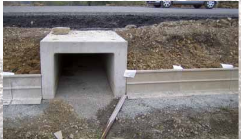
Amphibienleiteinrichtung und -durchlass während der Bauphase
