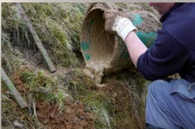
Einbau von Weidensteckhölzern mit Lehm-breiverguss
