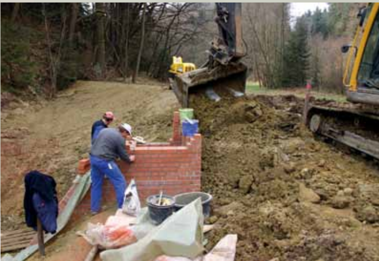
Bau eines Mönches an der Ziegenmühle
