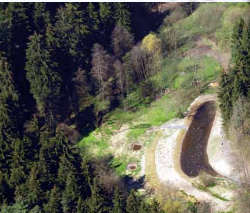
Teich und Kleingewässer im Eselsgrund nach Bauende
