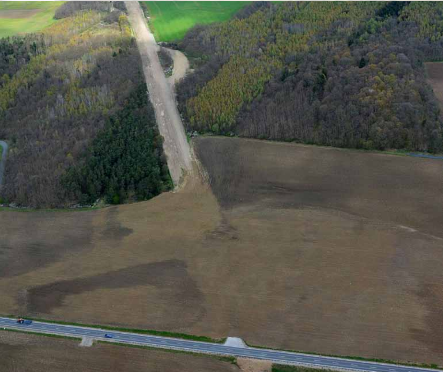
ehemalige Anschlussstelle Schorba und Parkplätze am Schorbaer Berg, 2016
